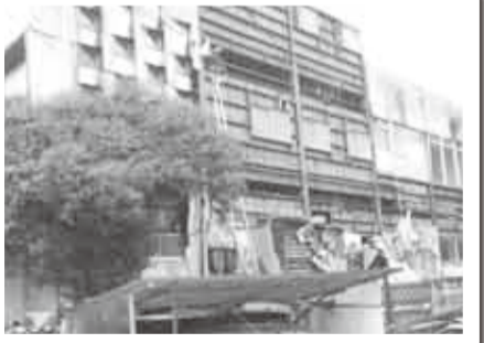
壁面が崩れた箱清水の食事処
