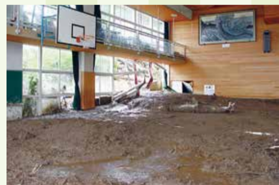
岡谷土石流災害(2006年7月19日発生、上の原小学校は裏山からの土石流が学校に流れ込み被災)
