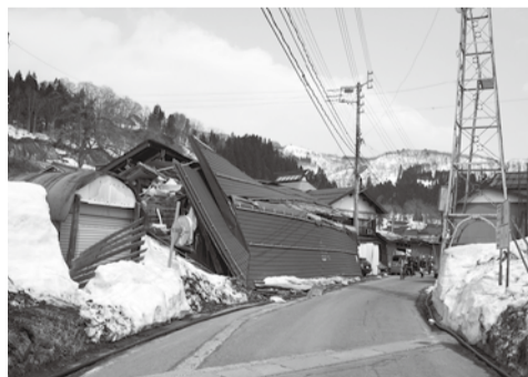
長野県北部地震で倒壊した米村の青倉公民館(2011年3月)
