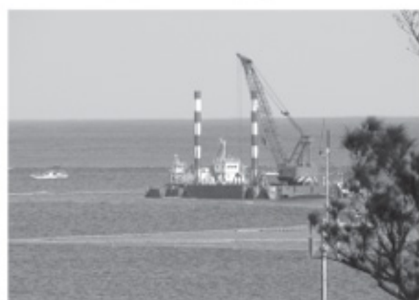
辺野古沖で行われているボーリング調査
